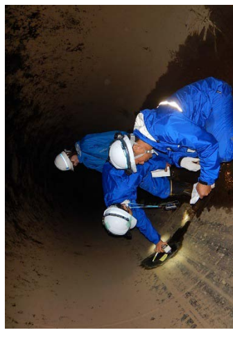
管水路の機能診断
