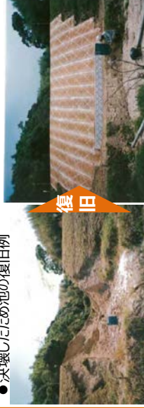
● 復旧と併せたため池改修（緊急放流工の設置）例
