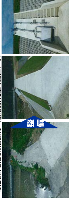
● 復旧と併せたため池改修（緊急放流工の設置）例
