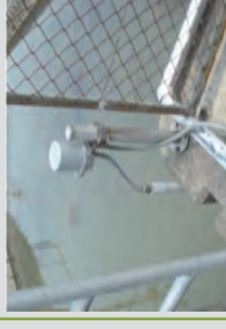
水位計の設置
