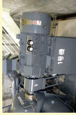
高効率電動機への更新
