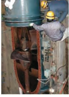
〔ポンプ施設の劣化状況調査〕
