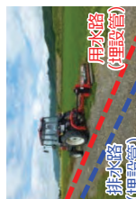
排水路（埋設管） 用水路 営農作業上の障害を除去する用排水路の管路化
