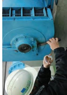
〔ポンプ設備を分解することなく、潤滑油採取による診断技術を確立〕
