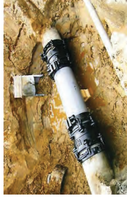
漏水防止のための整備
