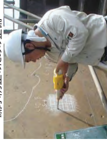
漏水防止のための整備
