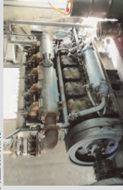
施設整備補修
