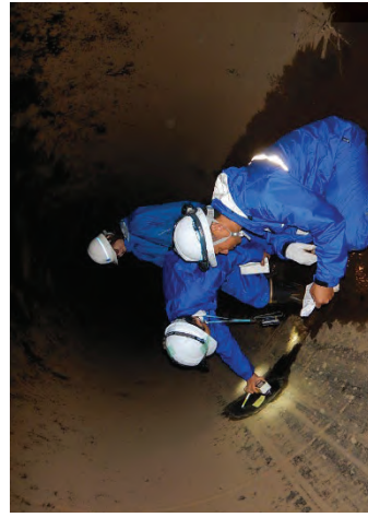
管水路の機能診断
