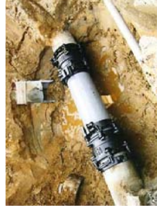
漏水防止のための整備
