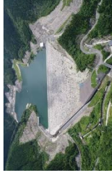
● 農業用ダム 河川をせき止め、用水を貯留・調整する施設
