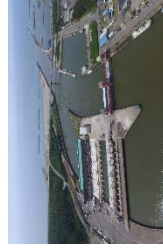
● 排水機場 河川や海面より低いほ場の水を汲み上げ、安全に地区外へ排水する施設
