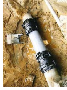
漏水防止のための整備
