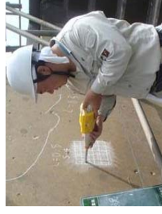
老朽化した施設の機能診断
