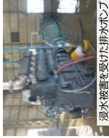
浸水被害を受けた排水ポンプ
