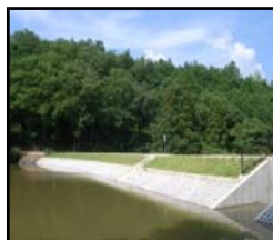
老朽化したため池の全面改修により洪水被害を未然防止
