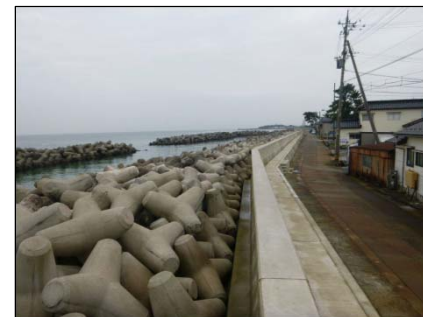
消波ブロックの設置や堤防高上げによる越波の防止
