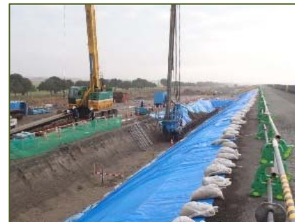
鋼矢板打設による耐震対策
