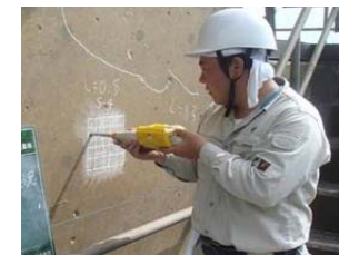
老朽化した施設の機能診断
