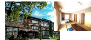
廃校を改修した大規模滞在施設
