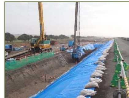
鋼矢板打設による耐震対策
