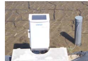
自動給水栓の導入
