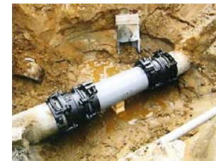
漏水防止のための整備
