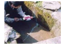
水路のひび割れ補修
