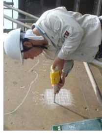
老朽化した施設の機能診断
