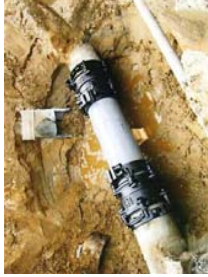
長寿命化のための整備
