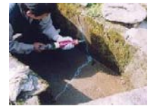
水路のひび割れ補修
