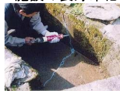
水路のひび割れ補修
