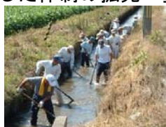
水路の泥上げ
