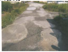
農道の窪みの補修
