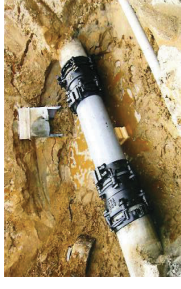
漏水防止のための整備
