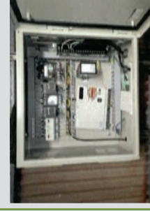
監視装置の設置
