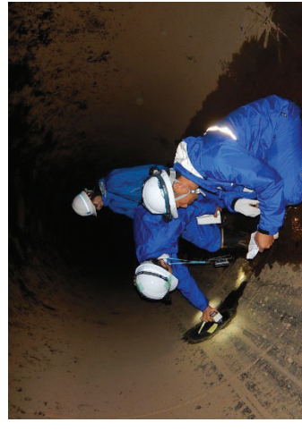
管路の機能診断
