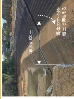
押さえ盛土による堤体の補強
