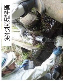
堤体からの漏水量計測
