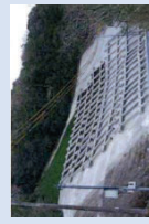
集落防災安全施設 (土砂崩壊防止施設)
