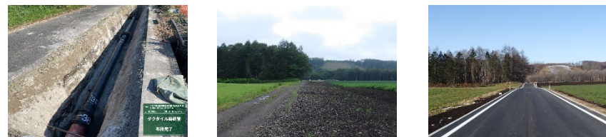
国営かんがい排水事業で一体的に施工
