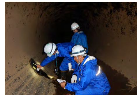
管水路の機能診断
