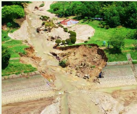
令和4年8月豪雨によるため池の決壊 (山形県川西町)
