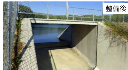
ため池の洪水吐きの改修(洪水流下能力の増加)
