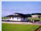
農業集落排水施設
