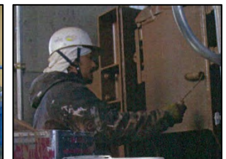
(ゲートの塗装)
