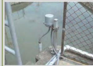
水位計の設置
