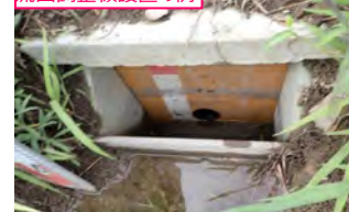
流出調整板設置の例
