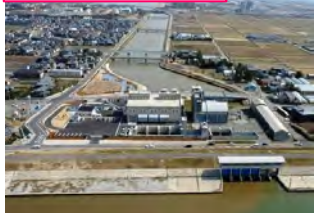
排水機場と周辺の市街地
