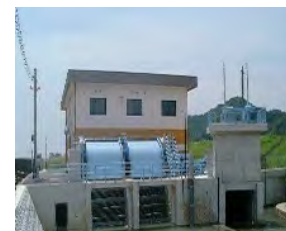
排水機場の整備
