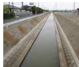
排水路の整備
