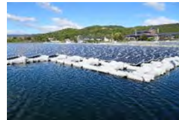
農業用ため池の水面に 設置された太陽光発電設備
