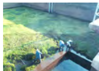
ファームポンドに繁茂した水草
