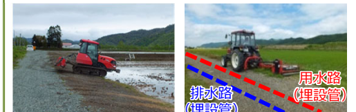
農機の旋回を容易にし、作業効率を向上させるターン農道の整備 営農作業上の障害を除去する用排水路の管路化
