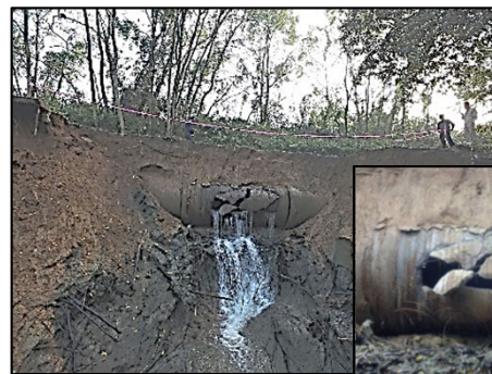
管水路における漏水事故 PC管の劣化
