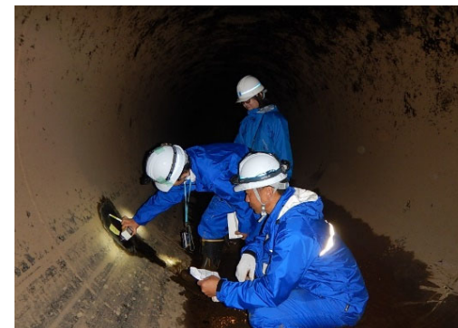
管水路の機能診断
