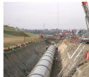
水路のパイプライン化
