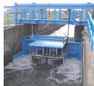
小水力発電施設の設置
