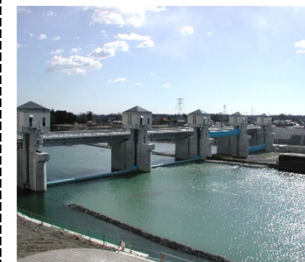
頭首工の改修
