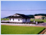
農業集落排水施設
