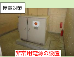
非常用電源の設置
