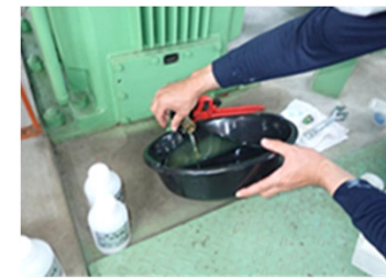
〔ポンプ設備を分解することなく、潤滑油採取による診断技術を確立〕
