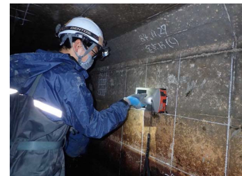
〔水路の鉄筋探査状況〕
