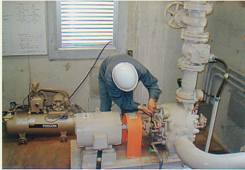
施設の点検・整備
