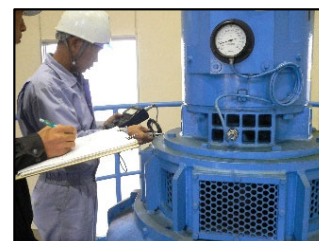
(ポンプの点検整備)
