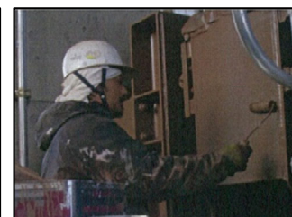
(ゲートの塗装)
