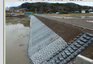
ため池護岸の整備
