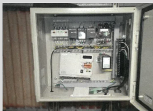
監視装置の設置
