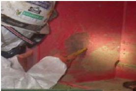
塗膜の剥離作業
