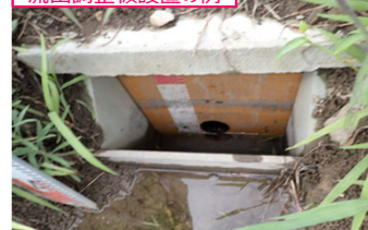
流出調整板設置の例
