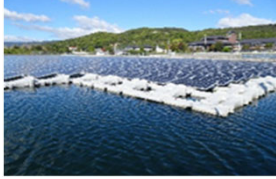
農業用ため池の水面に 設置された太陽光発電設備
