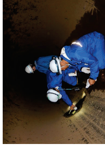
管水路の機能診断
