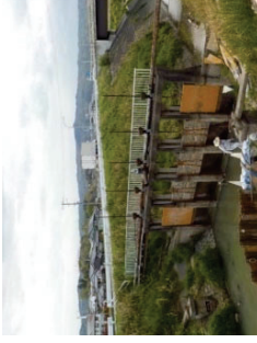
老朽化によりゲート操作ができなくなり 治水上支障がある頭首工の撤去
