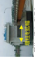
頭首工堰柱の耐震化
