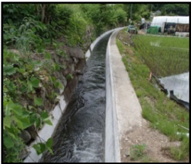
老朽化した用水路の整備・更新
