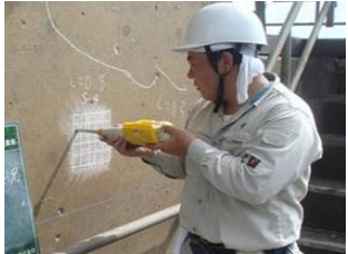
老朽化した施設の機能診断
