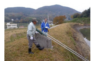
ため池の現地パトロール
