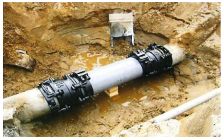
漏水防止のための整備
