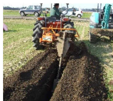
暗渠排水の整備
