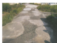
農道の窪みの補修
