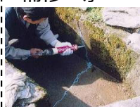
水路のひび割れ補修
