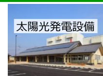
太陽光発電設備
