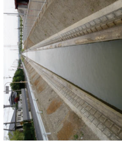
排水路の整備
