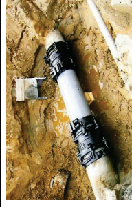
漏水防止のための整備
