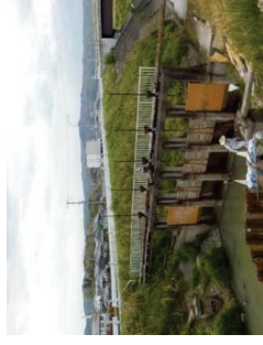
老朽化によりゲート操作ができなくなり 治水上支障がある頭首工の撤去
