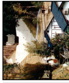
（治山施設による山地災害の未然防止）
