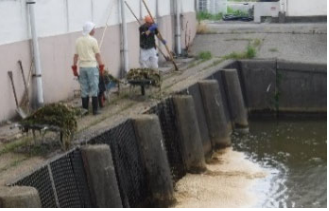
スクリーンの除塵作業
