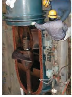
〔ポンプ施設の劣化状況調査〕
